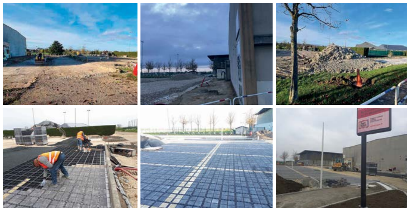
Les futurs parkings des installations sportives et de l'ALSH commencent à prendre forme. Objectif n°1 la sécurité des utilisateurs autour des bâtiments, en particulier pour les enfants.
